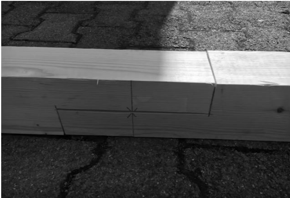
Zuschneiden der Sparren und Pfosten
